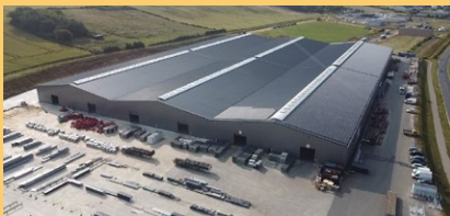
Une centrale photovoltaïque en toiture = 2 MW
